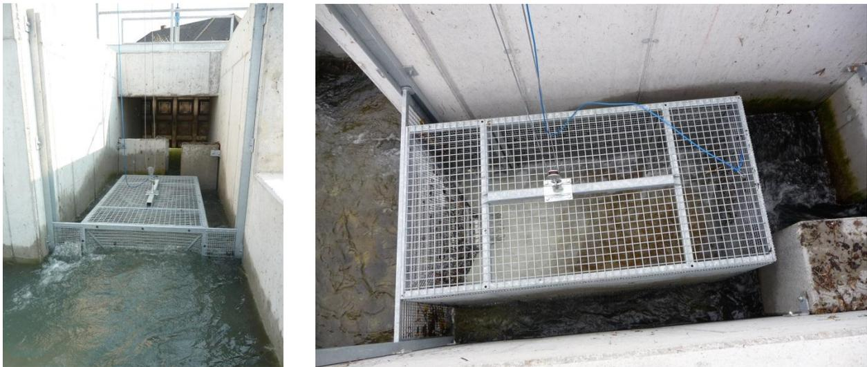
**Abb.3:** Reuse zur Kontrolle des Fischaufstieges
