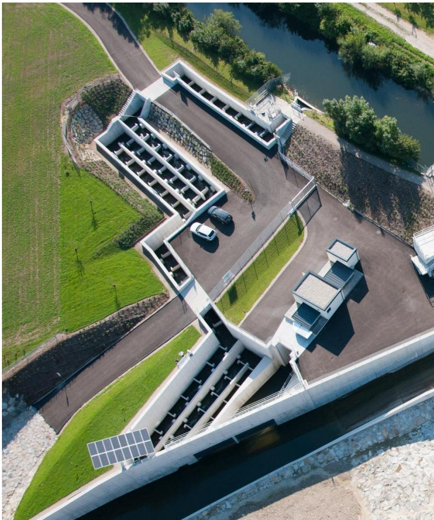
**Abb.1:** Fischeaufstieg beim Restwasserkraftwerk Greinsfurth.
