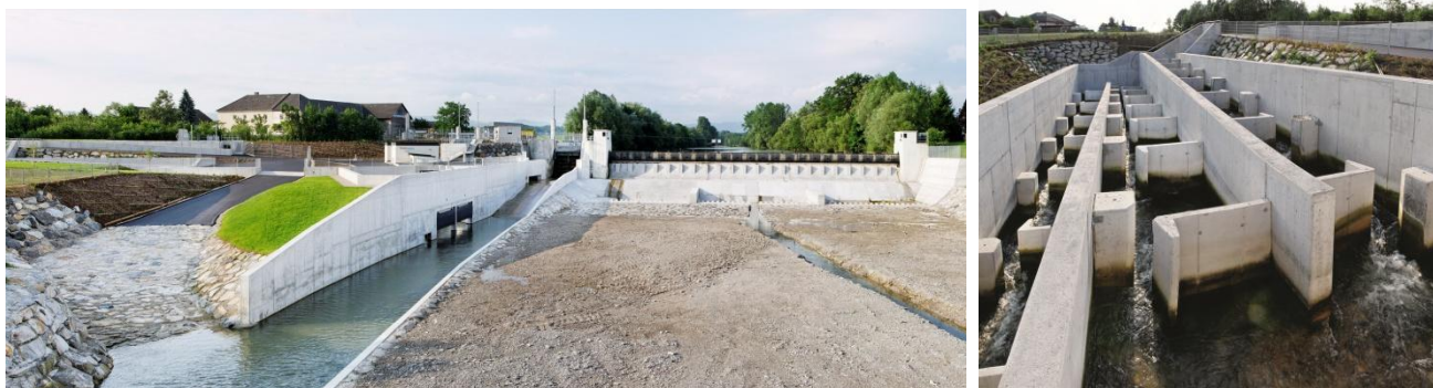
Bild1 : Die Wehranlage erstrahlt nach der Sanierung in neuem Glanz (hochaufgelöstes Foto hier )
