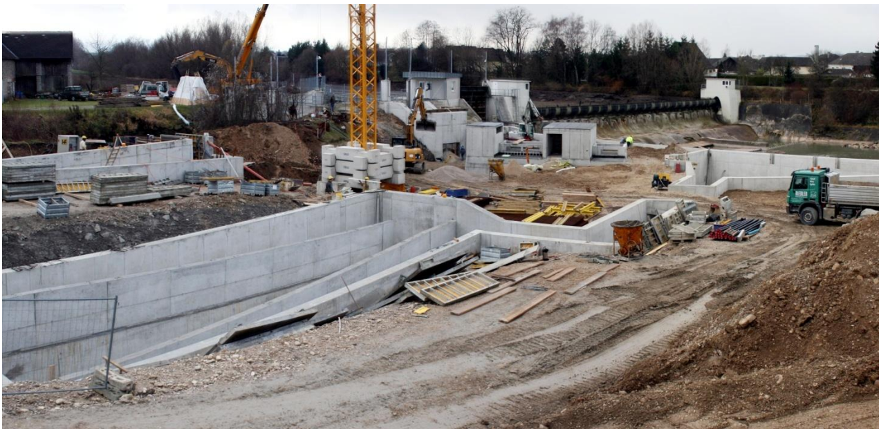
Bild: Bauarbeiten Fischaufstieghilfe und Restwasserturbine in Greinsfurth (hochaufgelöstes Foto hier )
